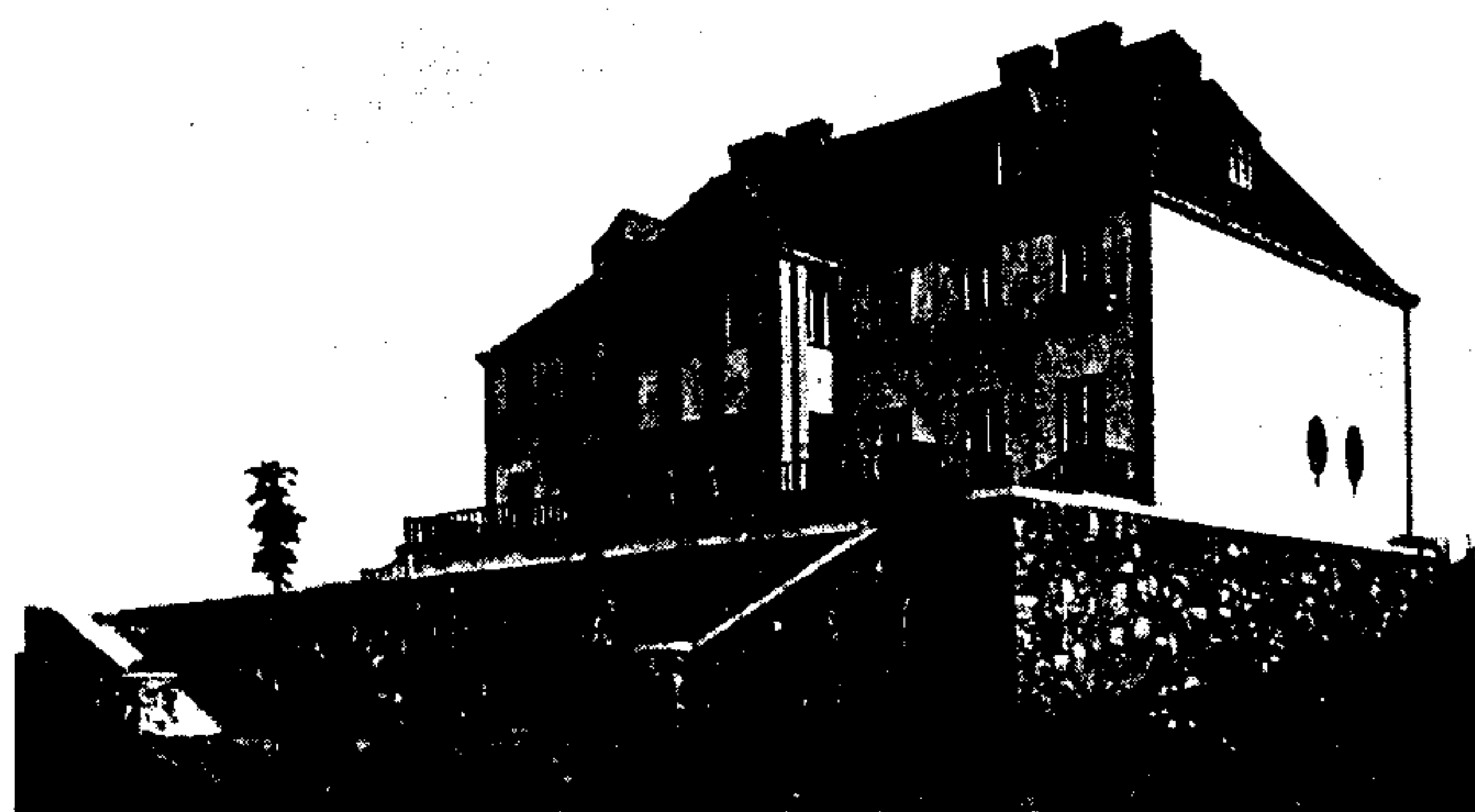
Berlova vila v Bruntále, vpravo detail fasády
